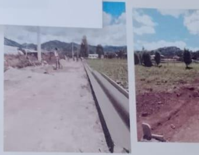
La construcción de estos contenes es parte de un modernizar las calles y garantizar que las lluvias comunidad
